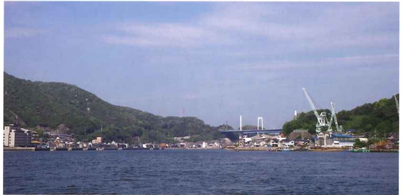
橋の左が本土、右側が向島です。
